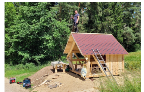
Aufbau der Wetterschutzhütte; Foto: Thomas Pickel
