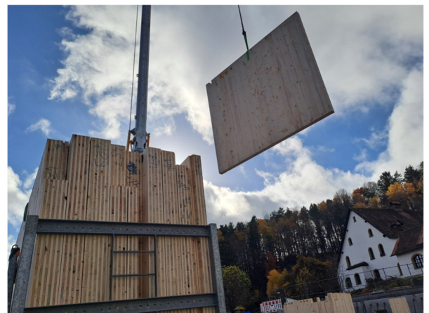
Anlieferung der Wandelemente
