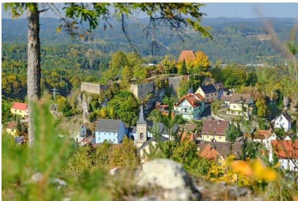
Blick vom Hirtenberg auf die Burganlage; Foto: H. Meidenbauer
